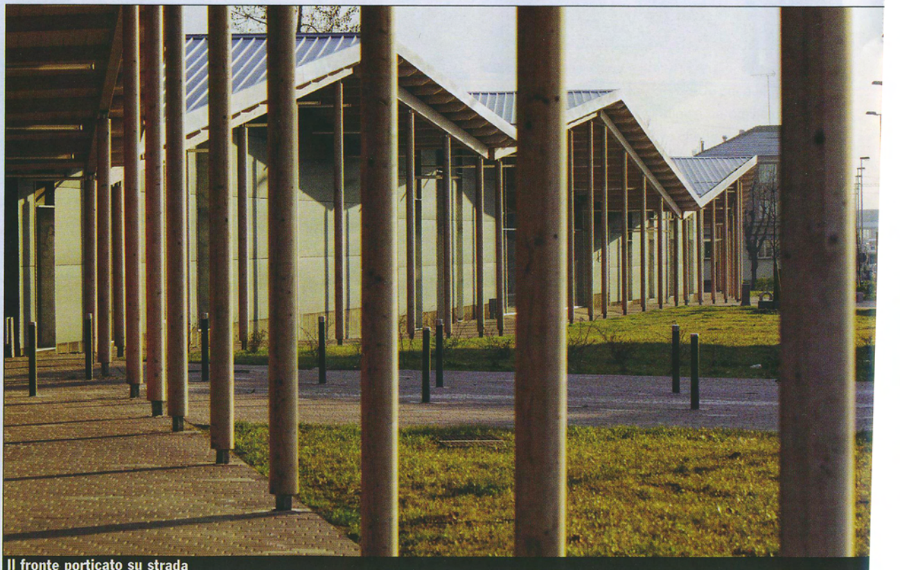
Il fronte porticato su strada
