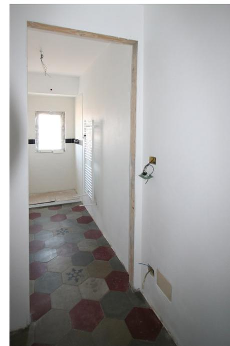
Le cementine presenti originariamente all'interno di alcuni ambienti sono state rimosse, pulite e riutilizzate per la pavimentazione dei bagni.
