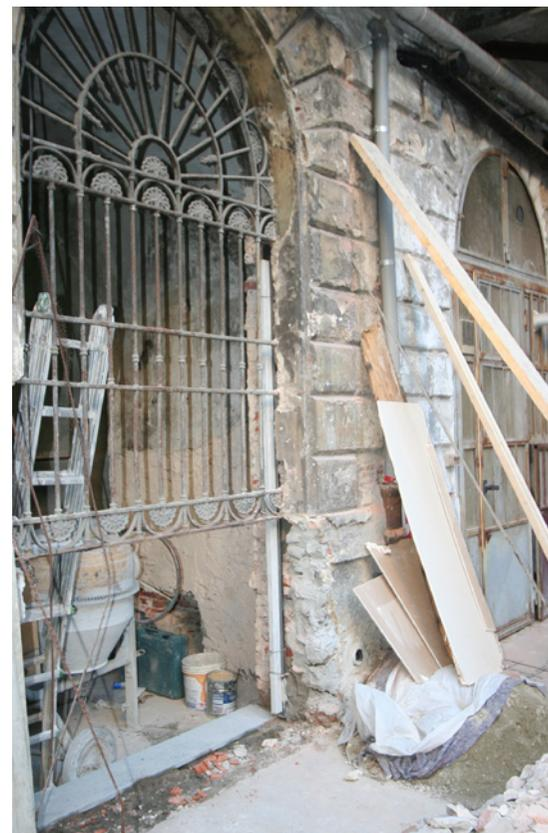
Allargamento delle aperture esistenti e realizzazione delle tre porte finestre previste da progetto
