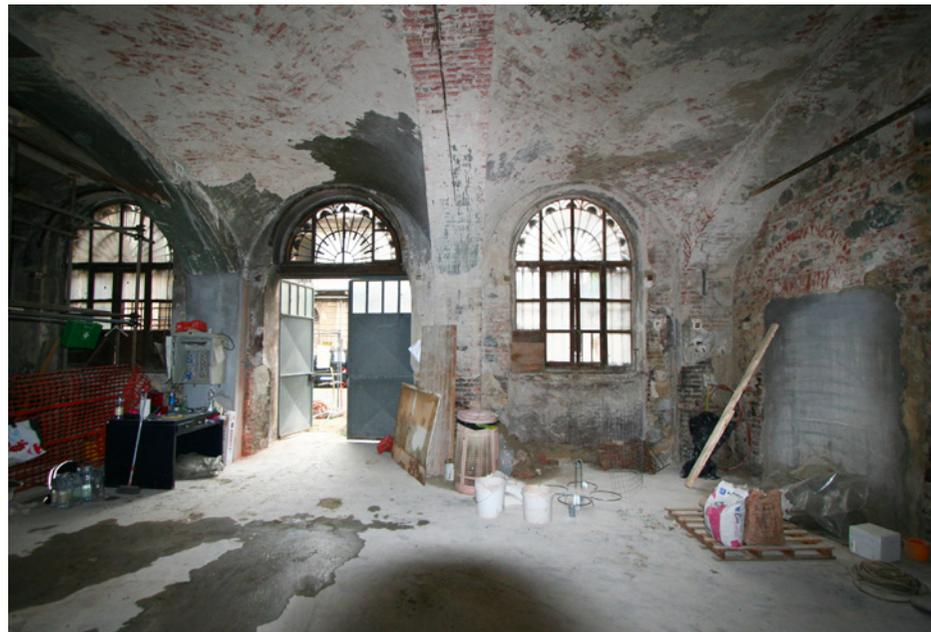
In alto. Stonacatura delle murature e delle volte in mattoni esistenti.
