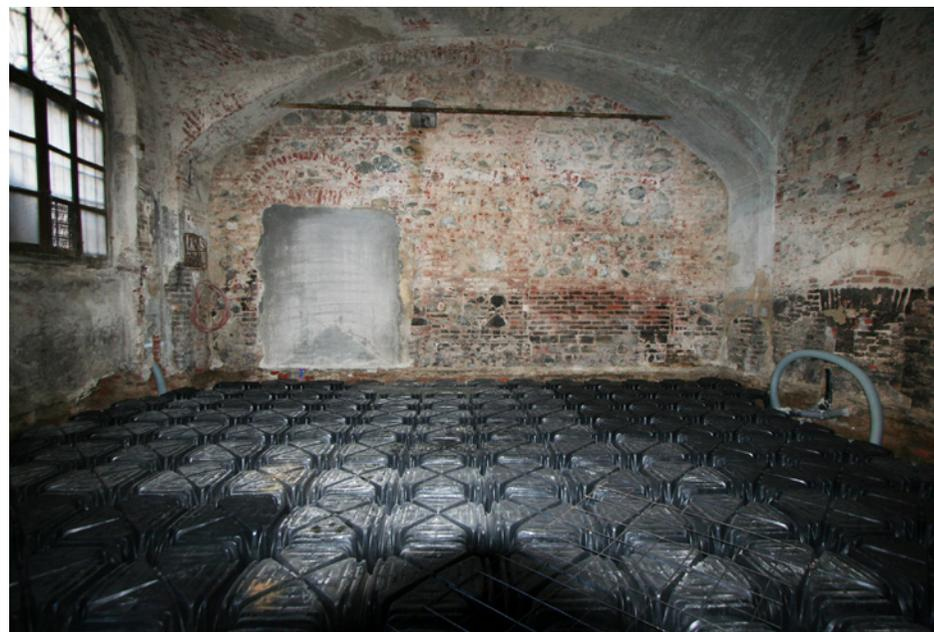
Le fasi di realizzazione del vespaio aereo: smantellamento del pavimento esistente e sbancamento, getto di pulizia, inserimento degli iglu, realizzazione del massetto
