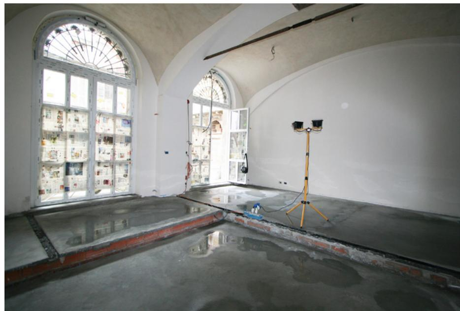
Realizzazione del getto elicoterato per la nuova pavimentazione interna
